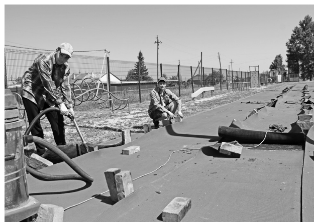
На стадионе «Лидер» ведётся ремонт беговой дорожки.
